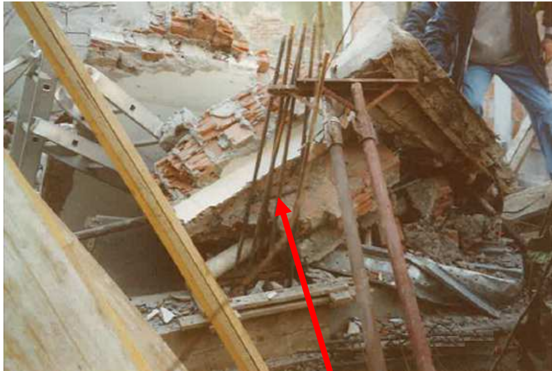
Armatura della colonna in costruzione
